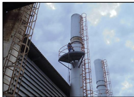
ปล่องระบายของหม้อน้ำ ขนาด 20 ตัน NO.2
